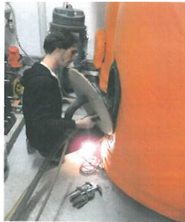
Renouvellement du revêtement de ballons ECS
